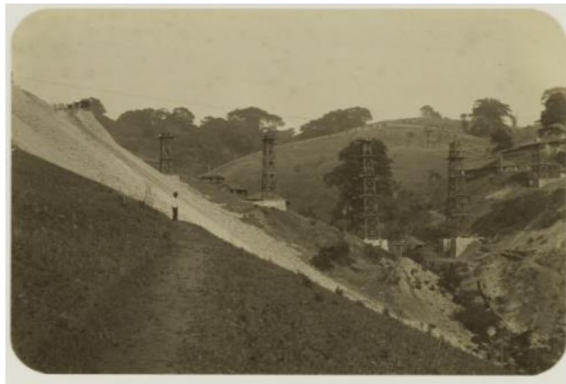
Foto 2. Proses Pembangunan Jembatan Sumber: KITLV 19320
