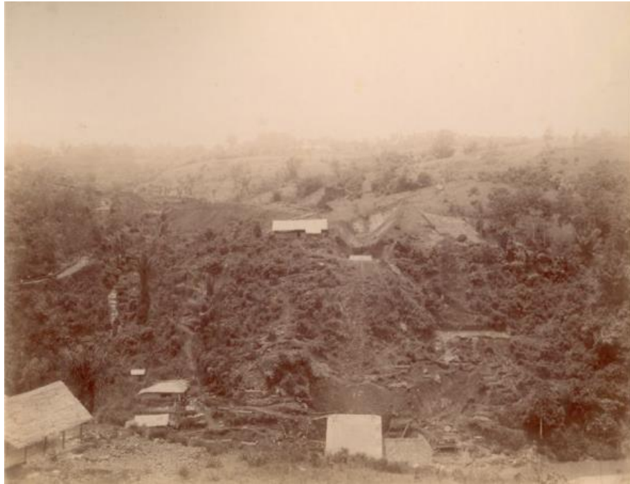
Foto 5. Proses Pembangunan Jembatan Cirahong Sumber: KITLV 100068
